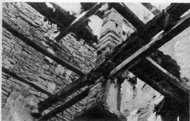
Селение Галанчож. Конструкция межэтажных перекрытий в жилой башне
