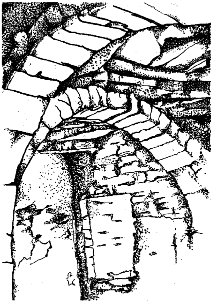
Рис.3. Ложносводчатое перекрытие в первом уровне родовой-боевой башни
