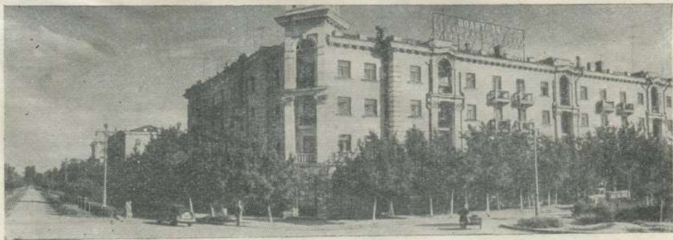
Жилой дом работников нефтеперерабатывающей промышленности на проспекте Победы. Авторы — архитекторы З. Беркович и Я. Беркович
