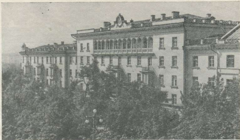
Жилой дом работников энергетической промышленности на проспекте Победы. Автор — архитектор Л. Хаит
